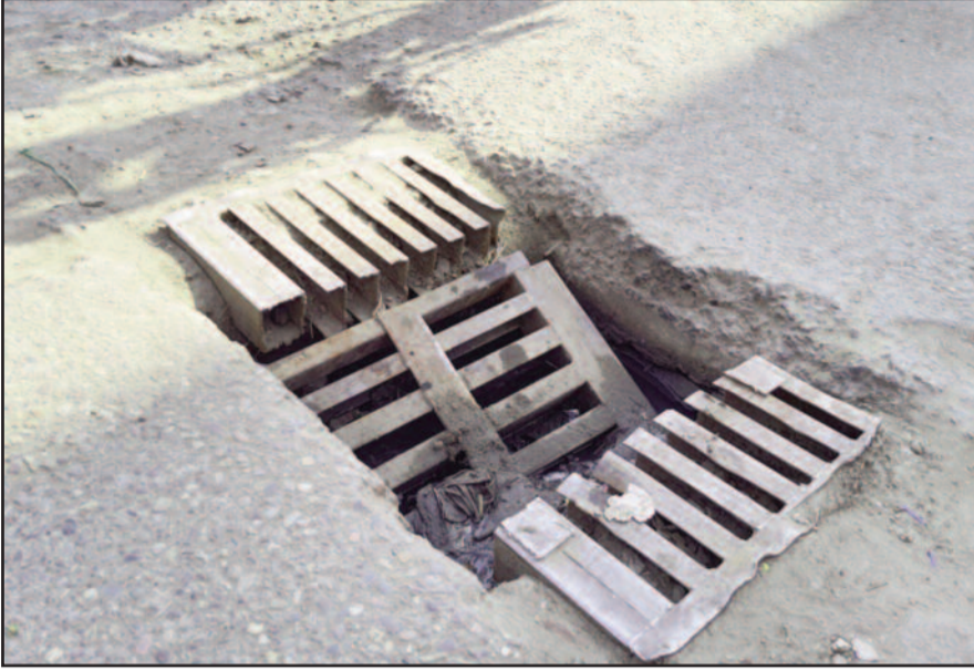
कोटद्वार के झंडाचौक के समीप सड़क पर क्षतिग्रस्त पड़ा चैंबर
