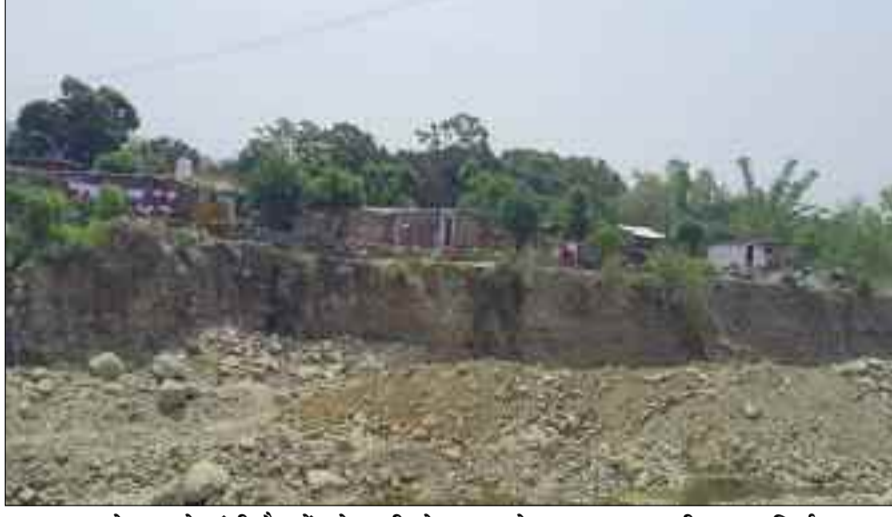
कोटद्वार के कुंभीचौड़ में खोह नदी के तट पर हो रहा बाढ़ सुरक्षा दीवार का निर्माण।
