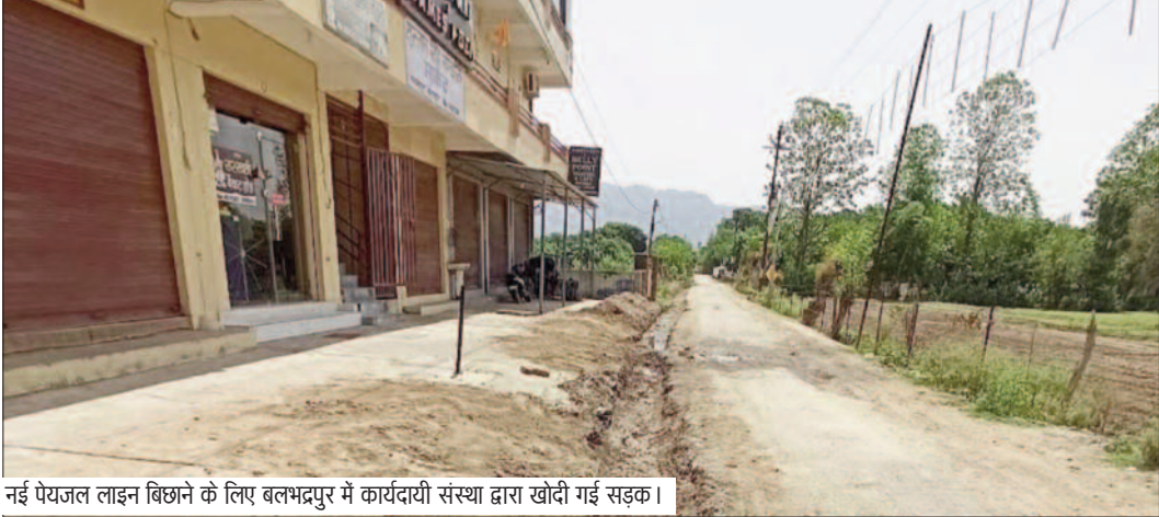
नई पेयजल लाइन बिछाने के लिए बलभद्रपुर में कार्यदायी संस्था द्वारा खोदी गई सड़क।
