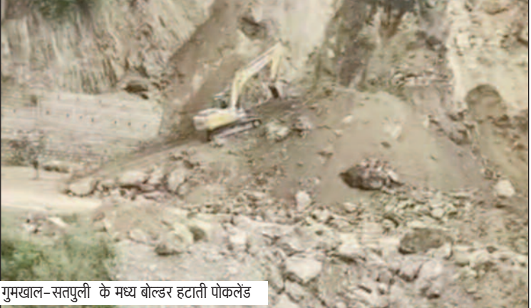
गुमखाल-सतपुली के मध्य बोल्डर हटाती पोकलेंटेंड
